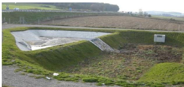
Figura 4-12-Sistema de tratamento de escorrências pluviais de vias rodoviárias na Áustria: Sistema de tratamento de águas que combina sedimentação e infiltração (adaptado de (Meland S.; Norwegian Public Roads Administration, 2016)
