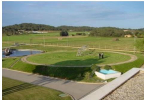
Figura 4-11- Sistema de infiltração rápida em Hostales de Pierola, Espanha (Torrens, 2020)
