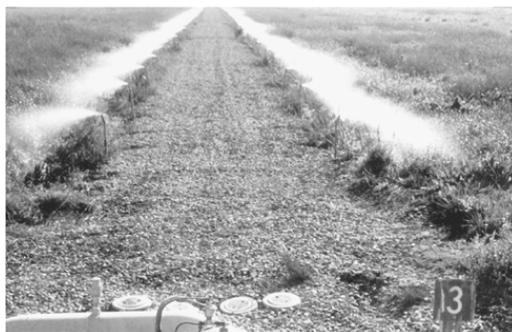
Figura 5-7 - Sistema de distribuição de baixa pressão implementado num talude, submetido ao sistema de OF em Davis, Califórnia (Crites, 2000)
