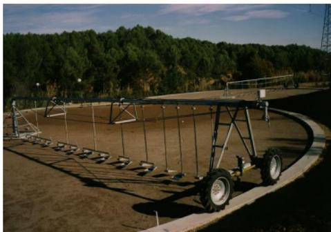
Figura 4-10- Sistema de infiltração rápida em Palamós, Espanha (Torrens,
