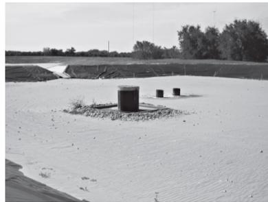
Figura 4-2- Bacia de infiltração rápida (Crites, 2000)
